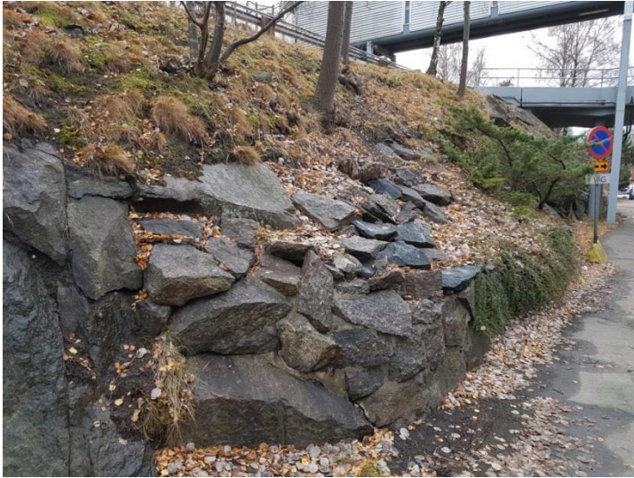
Figur 19. Löst liggande block ovan stödmur. Foto tagit mot söder.
