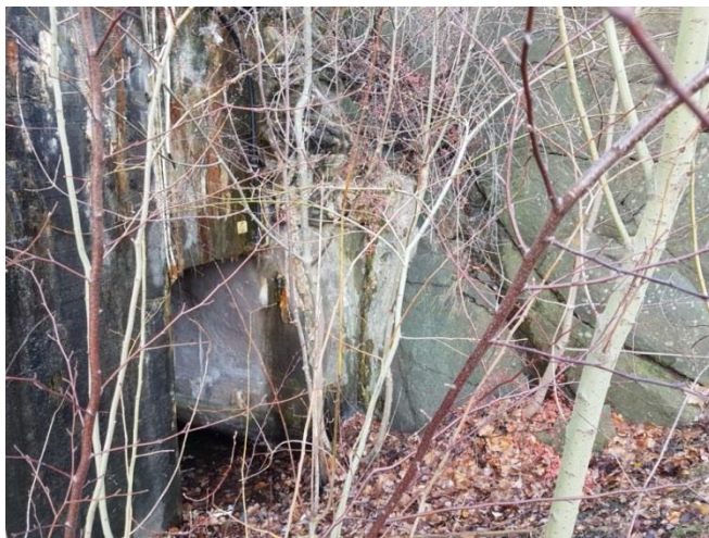
Figur 4 En insprängd anläggning gjuten i betong.
